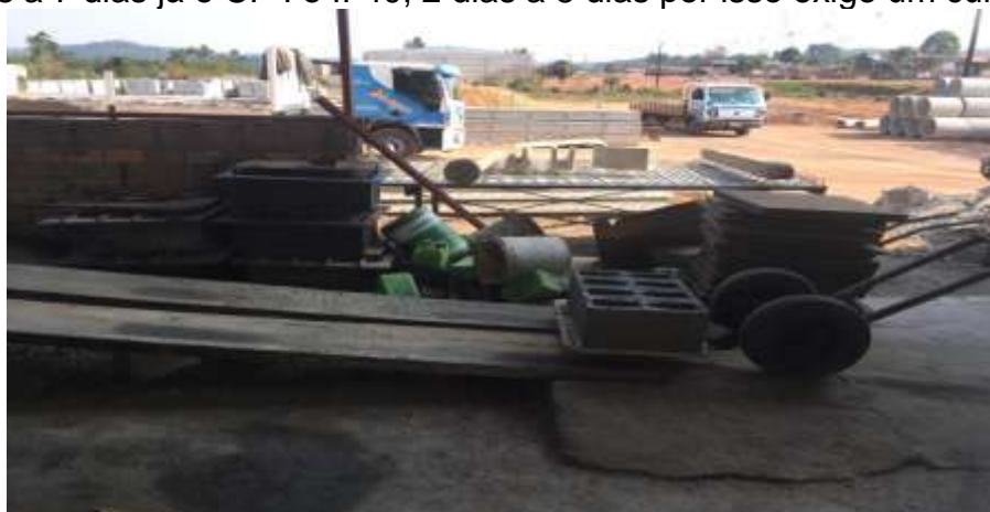
[...] retirada do bloco da máquina bloquera.
